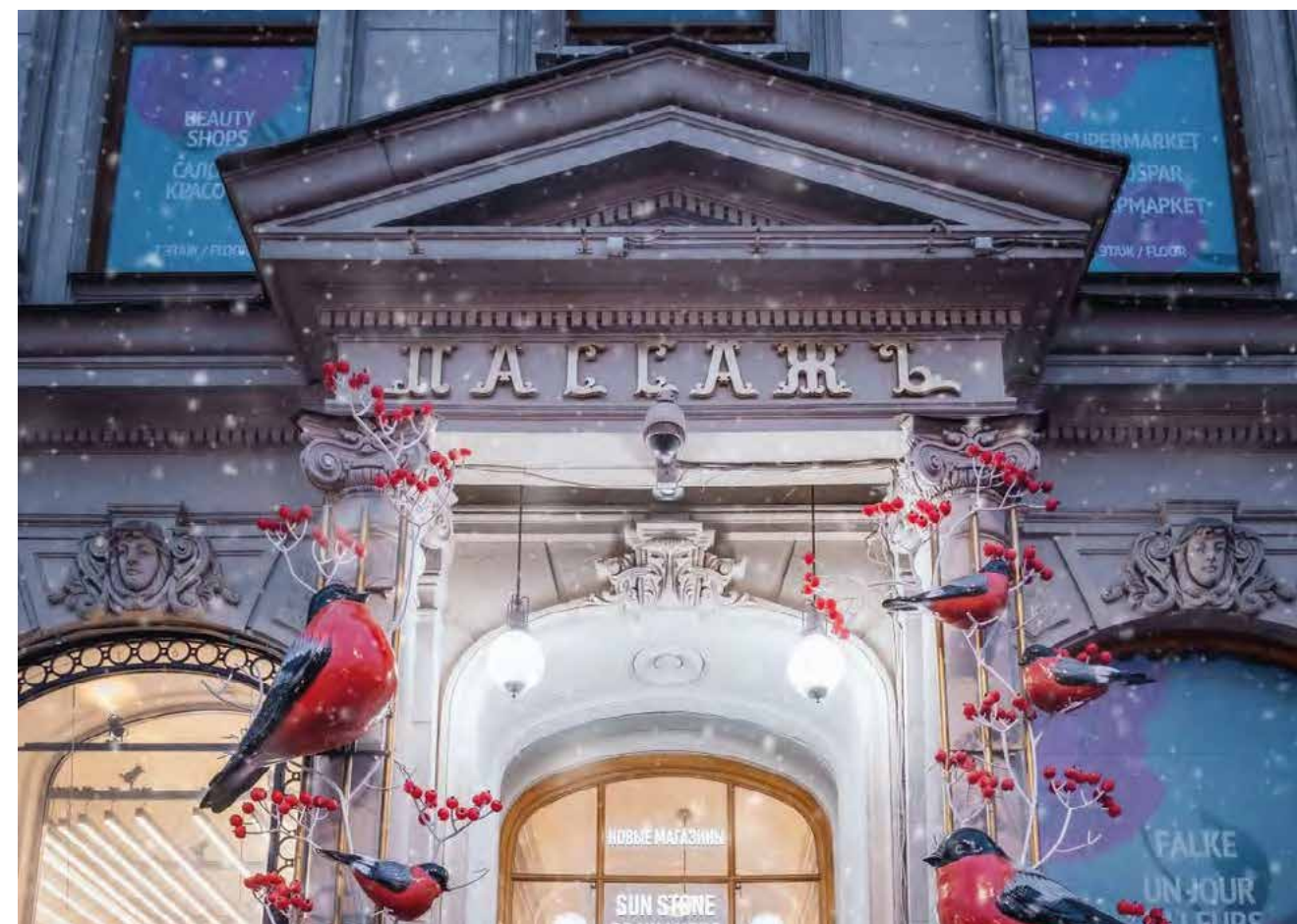
Торговый центр «Пассажь». Невский проспект, 48
